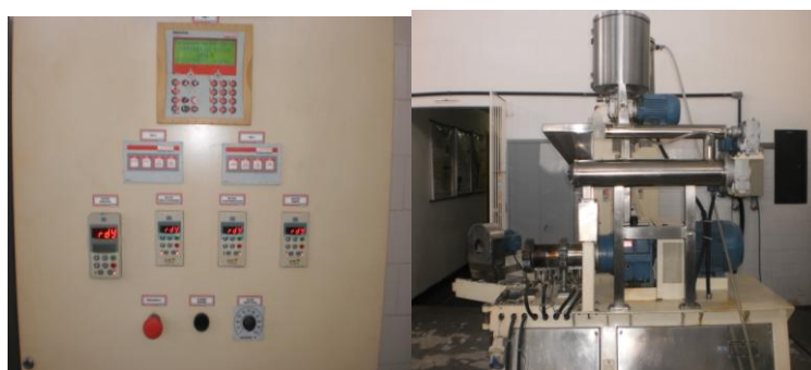
Figura 2. Painel de controle da extrusora e Extrusor monorosca, RXPQ. Labor 24.
